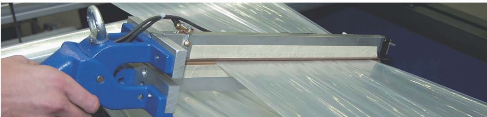
Verschweißen von Folienbahnen (inlines)
